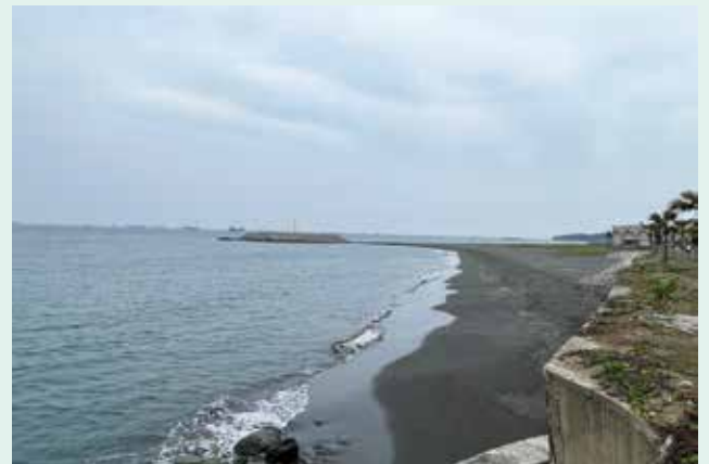
高雄旗津的離岸堤如今變成陸連島，沿岸沙灘景觀完全變形。
