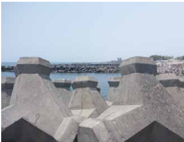
枋寮防波堤外的沙灘外已經堆置消波塊，但是外圍再堆置長方形消波塊，層層疊疊，是三層保障呢？還是消化經費預算？
