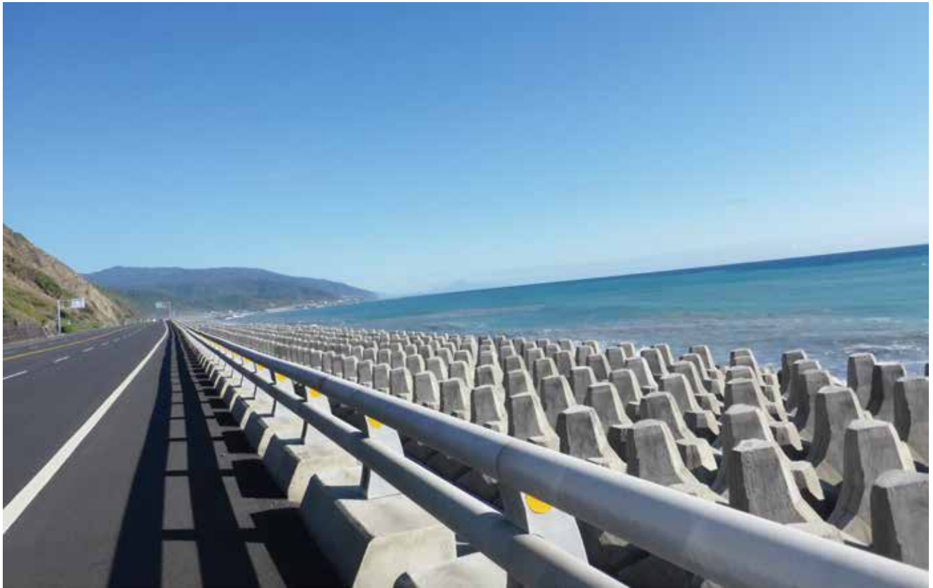
台東縣台九線濱臨太平洋綿延數十公里的消波塊保護工法，與海爭地，成為典型消波塊的「永續工程」。
